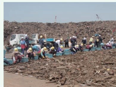
写真2-2-5 手作業で進められた 震災廃棄物の分別作業
