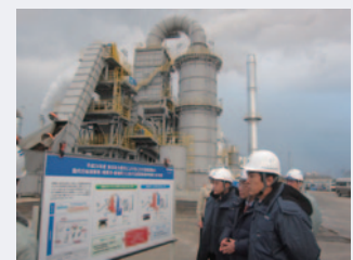
福島県相馬市仮設焼却炉(3基) (平成25年2月20日~本格稼働開始)
