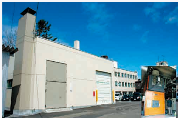
■地域熱供給施設
