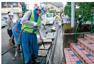
側溝の汚泥の除去
