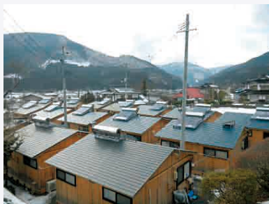
仮設団地（全景）
