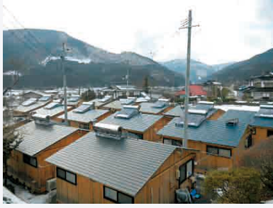
仮設団地（全景）
