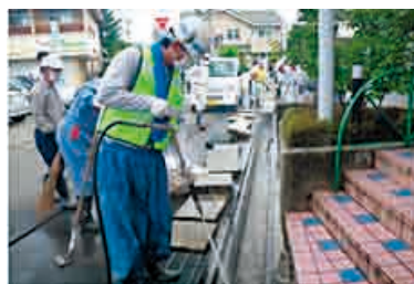
側溝の汚泥の除去
