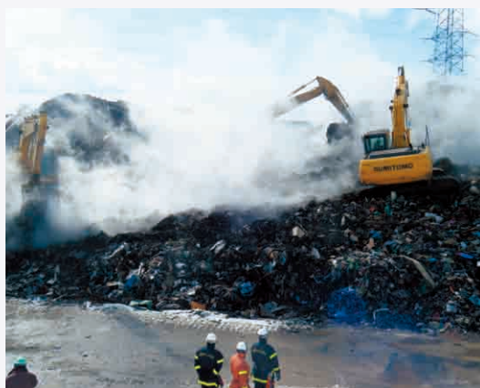
仮置場における火災の発生
