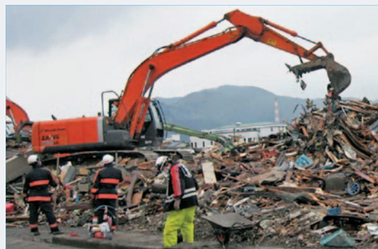
重機によるがれき等の撤去の状況
