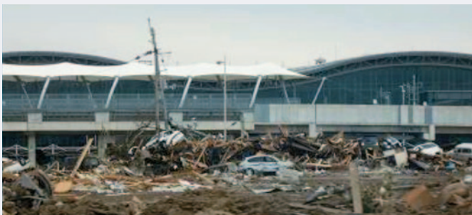
仙台空港駅前のがれき等の堆積状況
