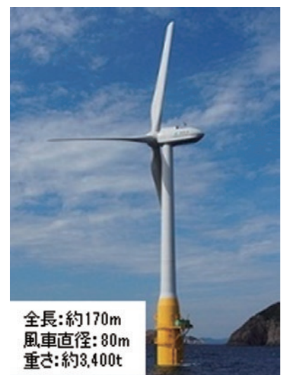
図2-1-2 浮体式洋上風力発電
