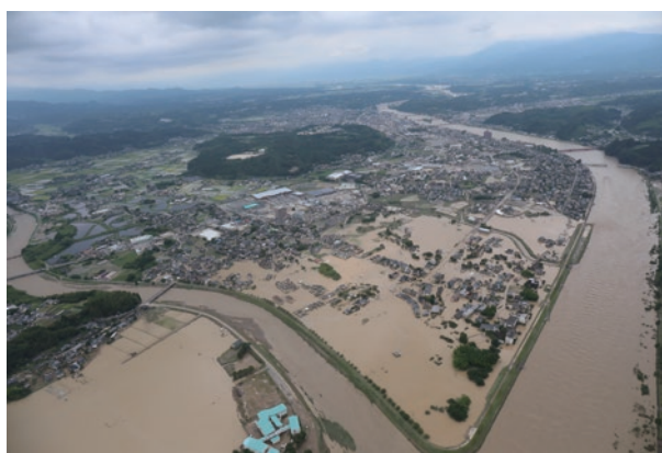
写真 1-2-3 令和2年7月豪雨の被害の様子
