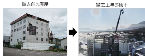
図2-3-4 官民連携で景観改善のための廃屋撤去の様子(阿寒摩周国立公園)
