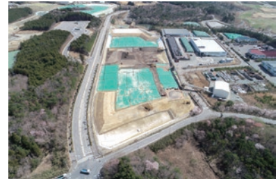
写真4-3-3 土壌貯蔵施設
