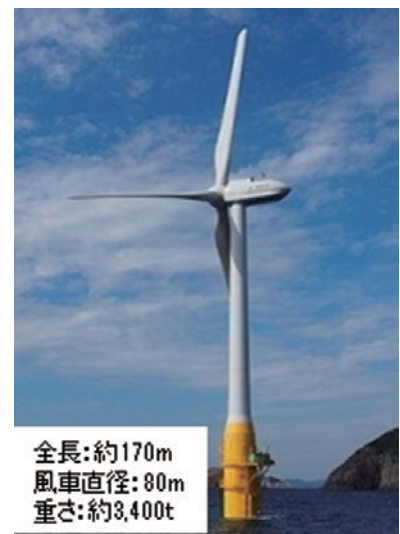
図2-1-2 浮体式洋上風力発電
