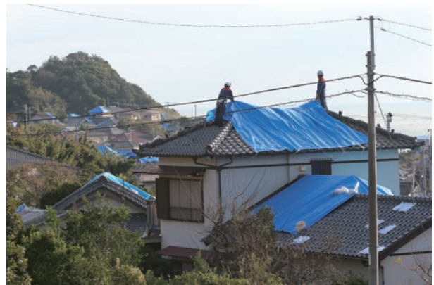
写真1-2-2 令和元年房総半島台風の被害の様子
