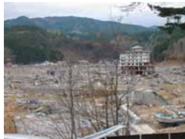
東日本大震災の被害の様子
