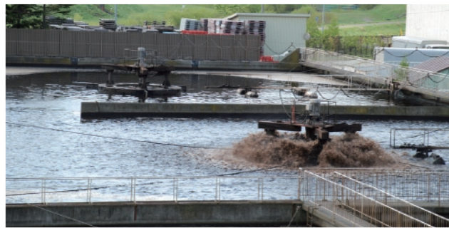
飲料メーカーの工場にある排水処理施設。排水を法律で定められた基準値を下回るように処理してから、河川や下水道に流します。
