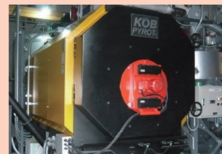
市内で作られたペレットを燃料とするペレットボイラー (写真提供：飯田市)
