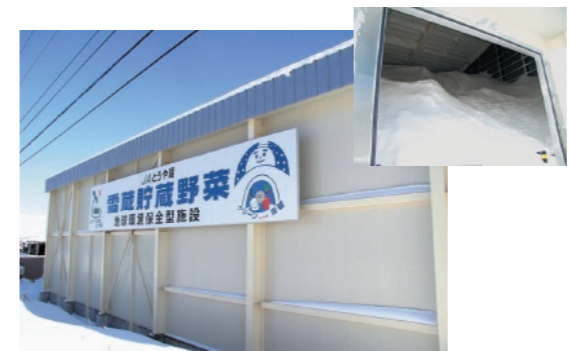
「新エネ百選」の一例。雪氷熱利用設備を導入し、野菜の低温貯蔵に利用(写真提供: 北海道 洞爺湖町)
