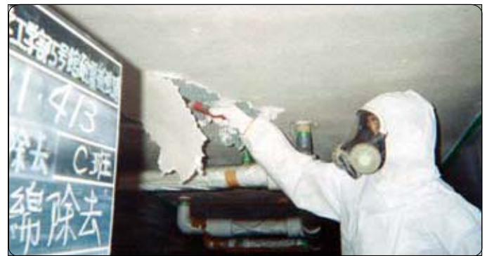
アスベストを取り除く作業。防護服を着て行います。 (写真提供：社団法人日本石綿協会)
