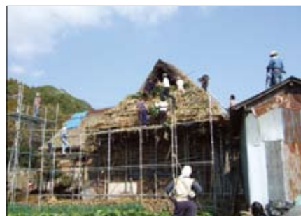
笹葺き屋根の修理
