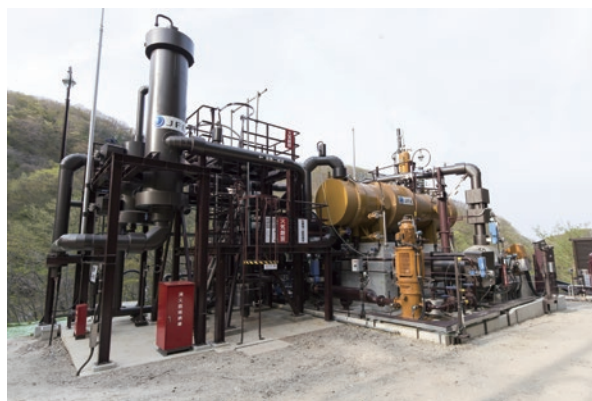
土湯温泉16号源泉バイナリー発電所
