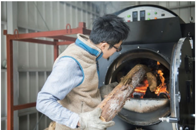
温泉施設の薪ボイラー
