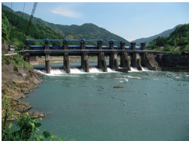
荒瀬ダム撤去前
