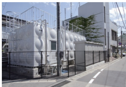
集中給湯設備外観
