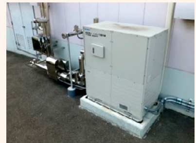
写真3-2-2 地中熱ヒートポンプ
