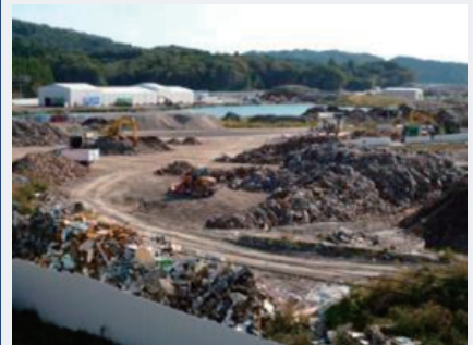
写真 1-2-2 岩手県山田町における仮置場の様子(平成24年10月時点)
