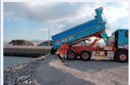
写真1-2-5 石巻港区廃棄物埋立護岸整備事業(平成25年2月20日開始)
