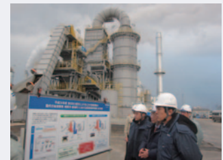
写真1-2-4 福島県相馬市仮設焼却炉(3基)（平成25年2月20日本格稼働開始）
