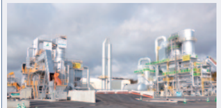
写真1-2-3 気仙沼ブロック気仙沼処理区 小泉地区の仮設焼却炉(2基) (平成25年1月29日試運転 開始)
