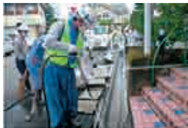
側溝の汚泥の除去
