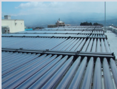
中心市街地にある環境配慮型施設 屋上の太陽光発電により、屋内住宅施設の給湯や床暖房、空調等のエネルギーを供給している。
