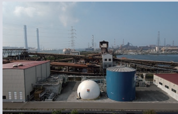
バイオガス化施設 資料: 千葉市
