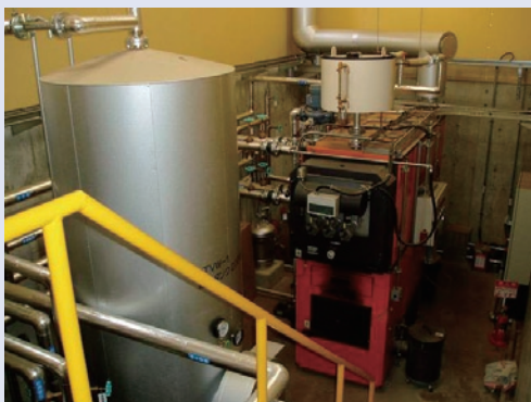
写真3-3-2 秦野市表丹沢野外活動センターの木質バイオマスボイラー
