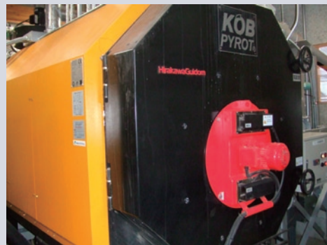
市内で作られたペレットを利用するペレットボイラー ペレットボイラーは、ペレットの需要が大規模であり、夏を含め通年であることが多く、ペレット利用の促進のために果たせる役割は大きいものがあります。
