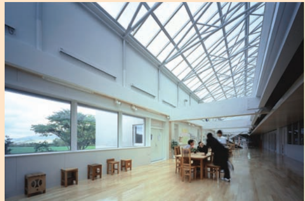
北海道黒松内中学校の自然光に溢れた「ひかりのみち」 写真提供：(株)アトリエバンク 撮影：吉田誠
