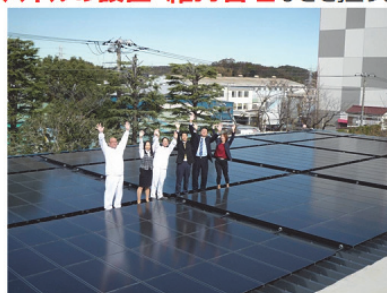
株式会社大川印刷の工場に設置された太陽光発電
