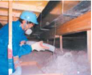
天井の断熱改修
