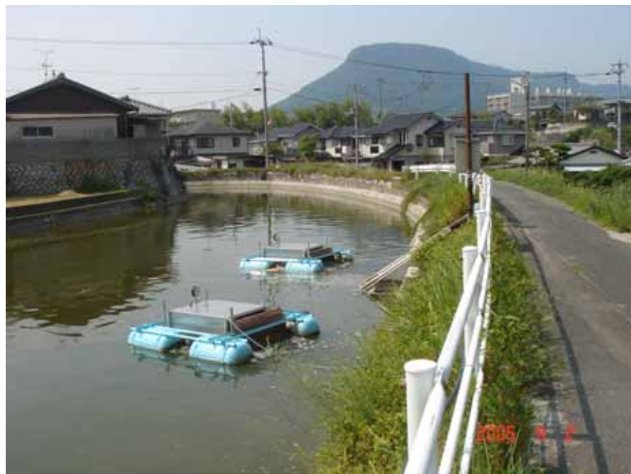
写真1 実証対象機器の設置状況（長池）
