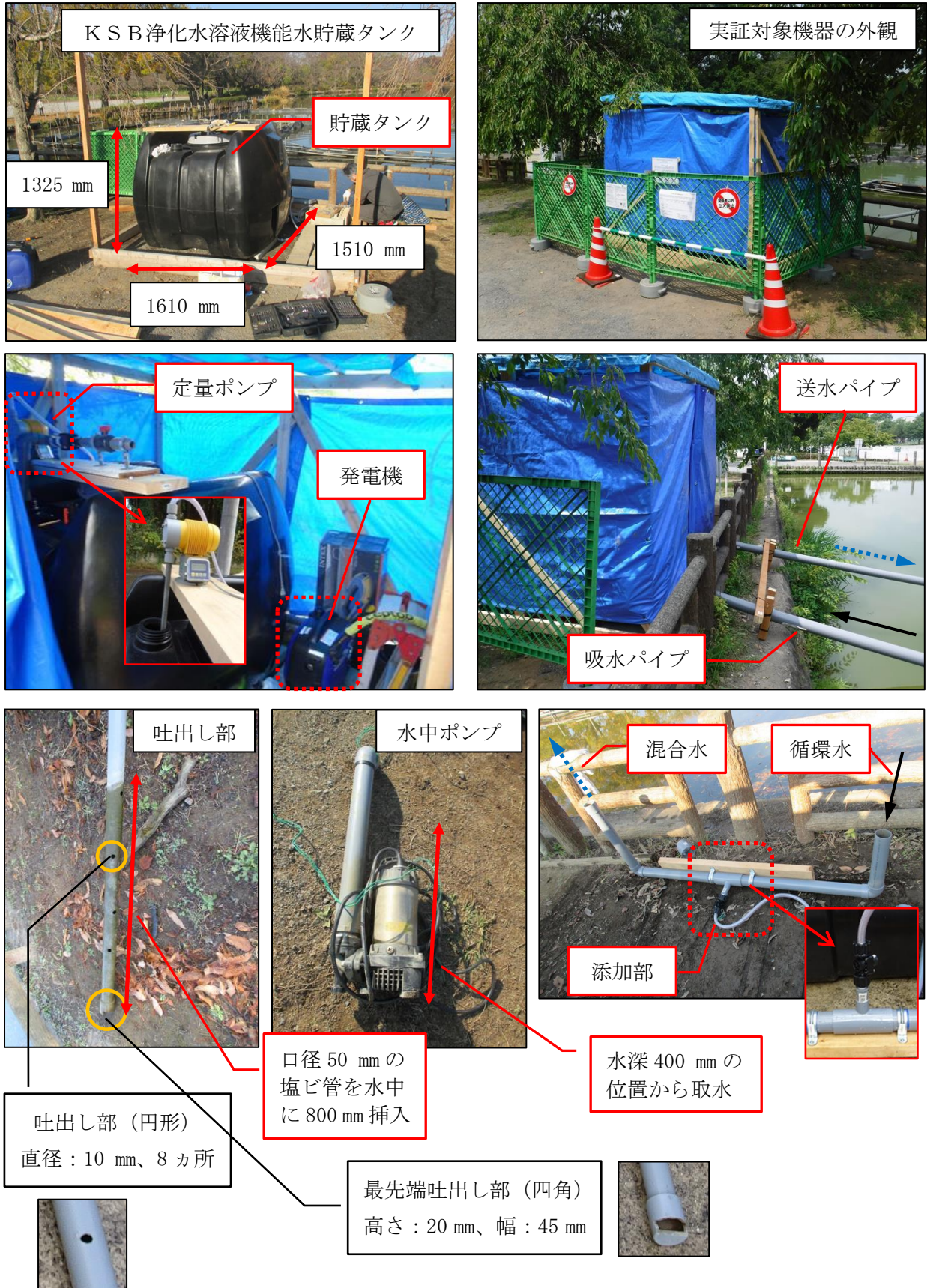
図 2-2 試験実施場所における実証対象機器等の外観
