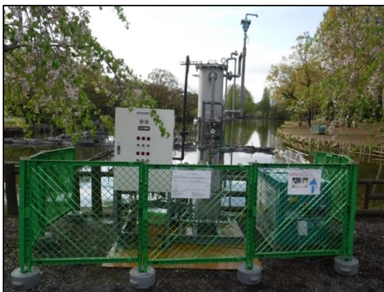
実証対象機器の設置状況
