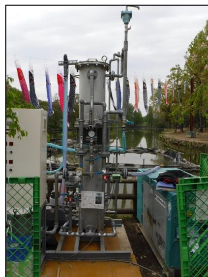
高速凝集ろ過塔
