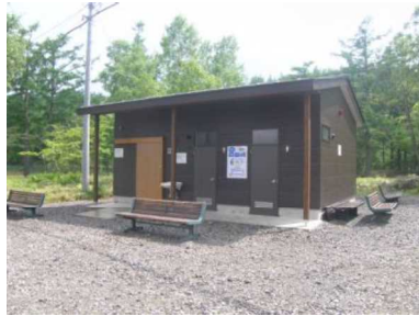
↑写真：実証施設外観
