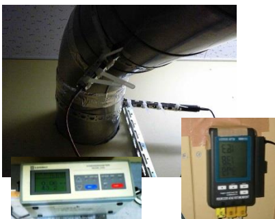
排気温度・風量の測定
