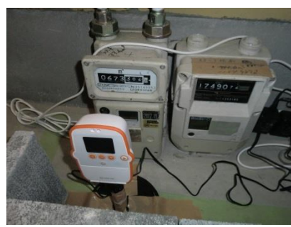
ガス使用量の監視
