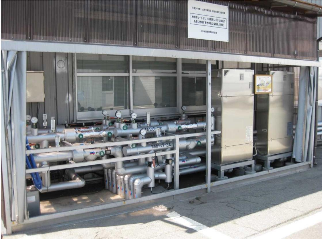
写真3-2 ヒートポンプとヘッダー、配管、計測器など
