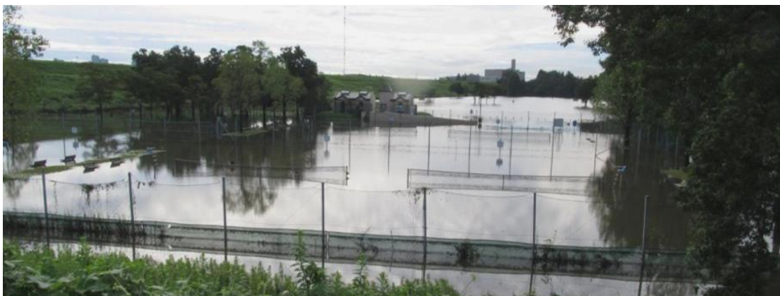
写真② 平成 27 年 9 月 11 日(金) 8:00 撮影 (冠水:約 100 センチ)
