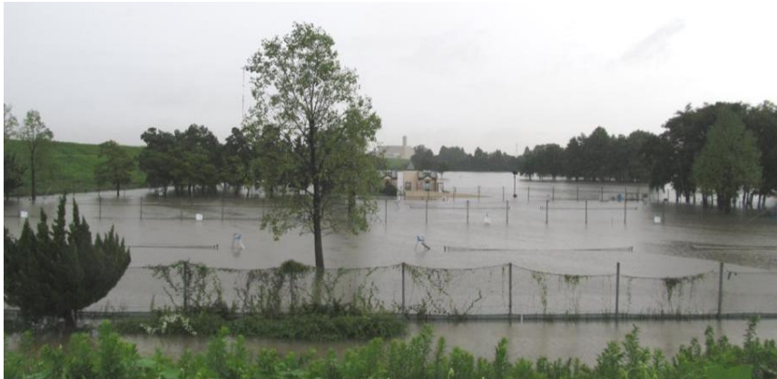
写真① 平成 27 年 9 月 10 日(木) 10:00 撮影 (冠水:約 120 センチ)
