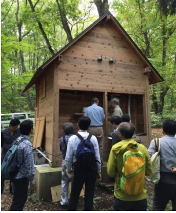
写真⑤ 背面から処理装置の点検口を望む様子 ※平成 27 年 9 月 29 日撮影 (写真⑤～⑨)
