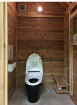
写真⑩ トイレブース
