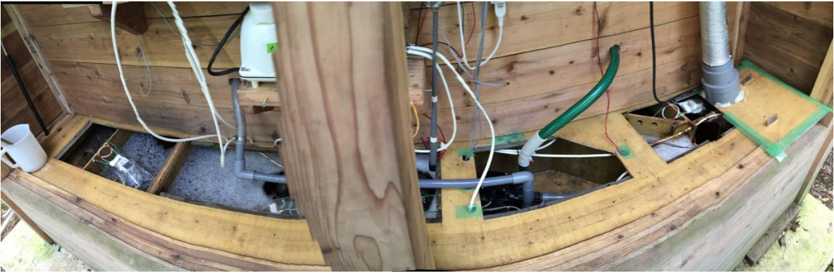
写真⑥ 処理装置の点検口
