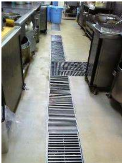
実証試験実施場所の排水溝
