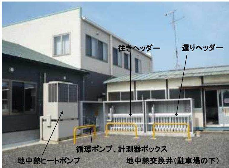
写真 3-1 室外設備の全景
