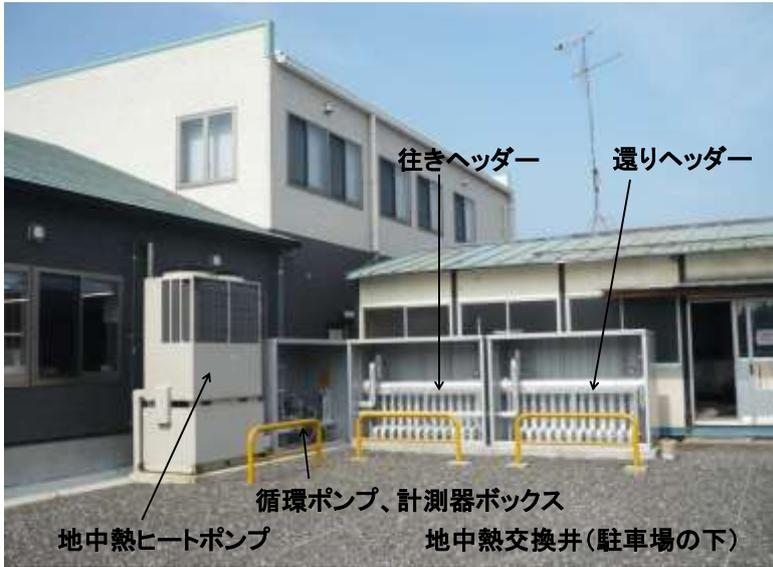
写真1 室外設備の全景
