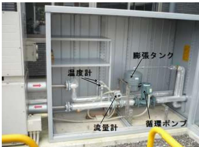
写真 3-3 循環ポンプと計測部
