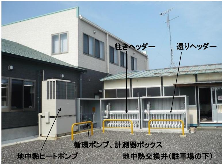
写真1 室外設備の全景
