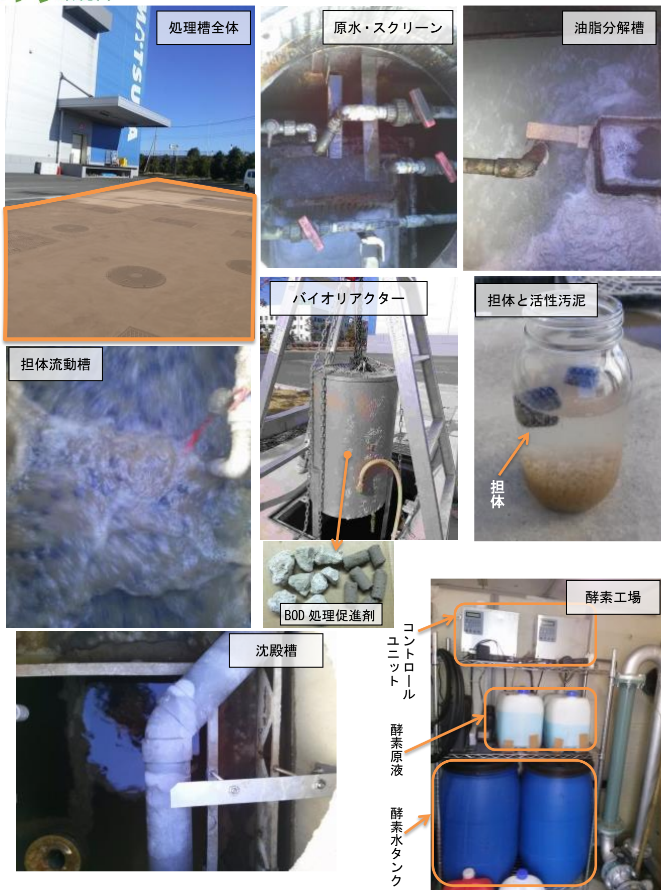
図 3-4 実証試験場所の主な単位槽の状況
