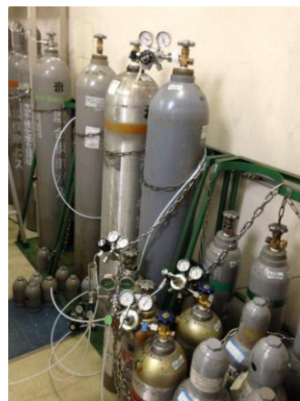
試験用高压ガス
