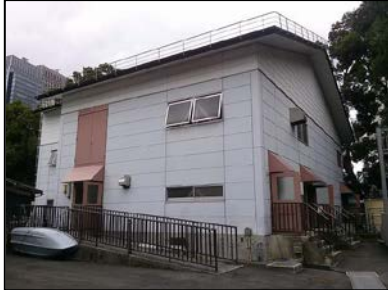
図① 浄化施設の外観
