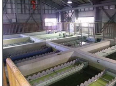
図② 精密ろ過槽
