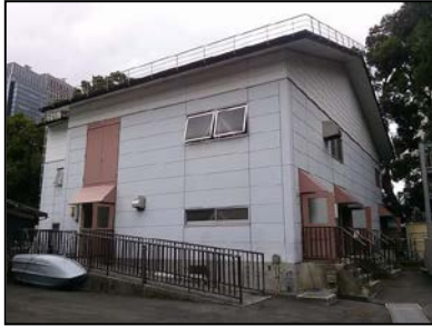
図3-3 浄化施設の外観
