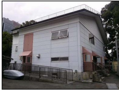
図① 浄化施設の外觀
