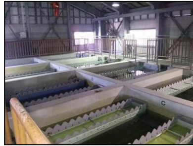
図② 精密ろ過槽
