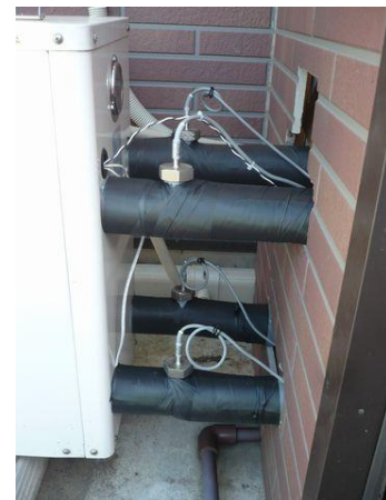
写真4 ヒートポンプ入口出口温度計
