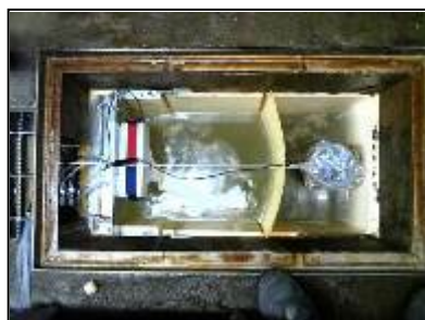
実証対象機器設置状況
