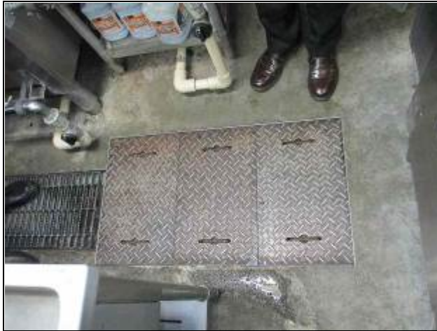
① 厨房内の油脂分離槽
