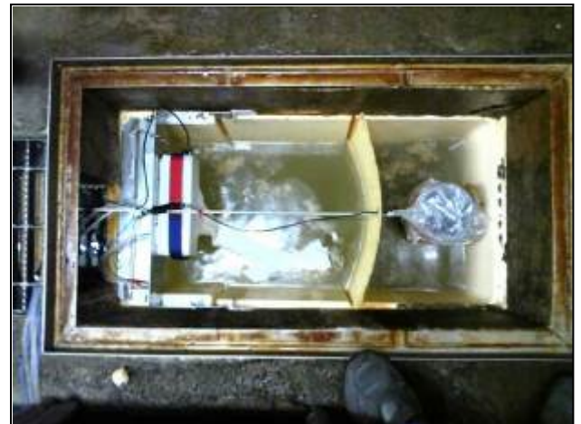
② 油脂分離槽内への設置状況 （1槽と2槽の間仕切りは取り外し）
