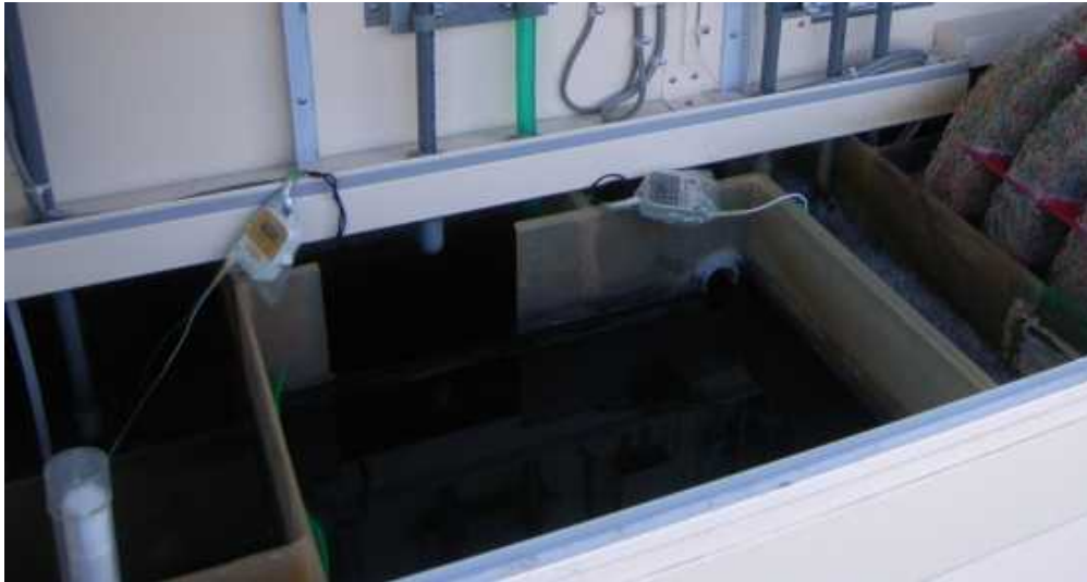
写真 5-4-1-7 処理水槽の水温 (温度センサーの設置状況)
