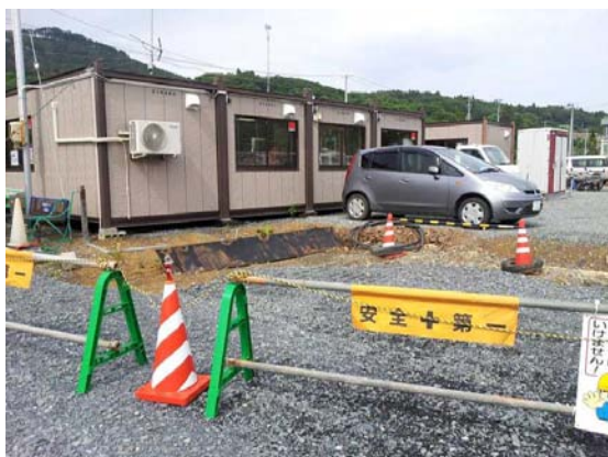
① 設置前状況: 災害後盛土に碎石を撒いてあった。
