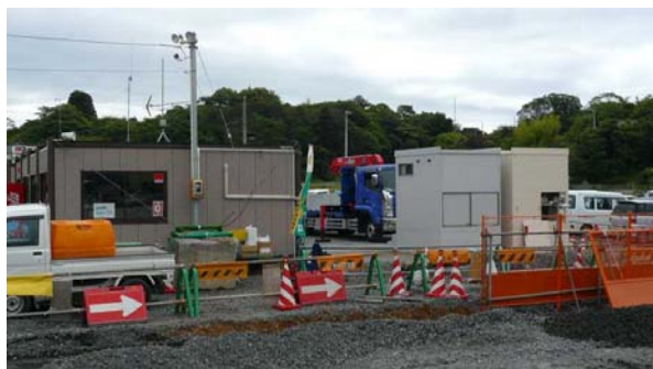
③トラッククレーンで据付設置状態
