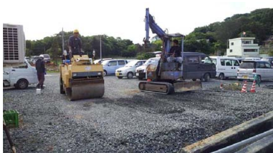
② 盛土をして碎石を転圧した。
