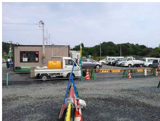
幅5m×奥行き3m、高低差30cmを埋める工事。
