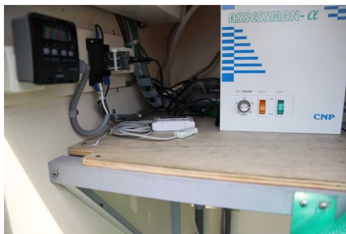
写真 5-4-1-6 処理装置内の温度・湿度 (温湿度センサーの設置状況)
