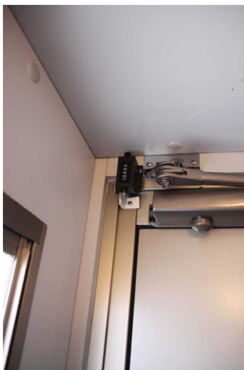
写真 5-4-1-2 利用者カウンターの設置状況
