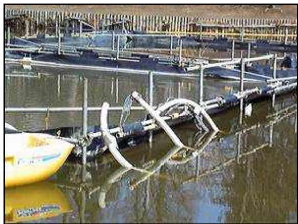
送泥・排水ホース
