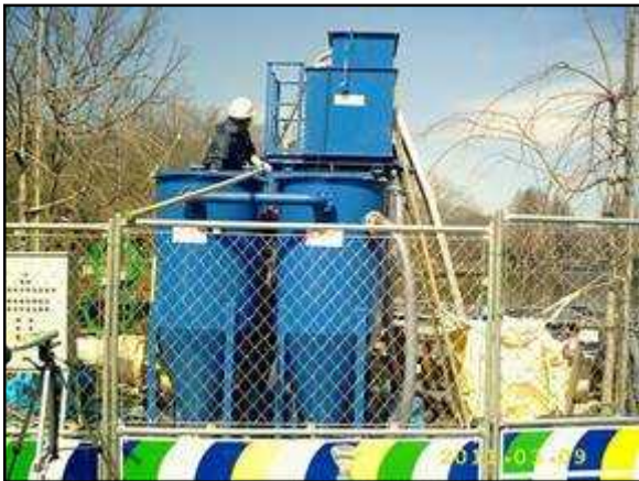
(上)自動スクリーン (左)底泥濃縮槽、(右)水循環槽
