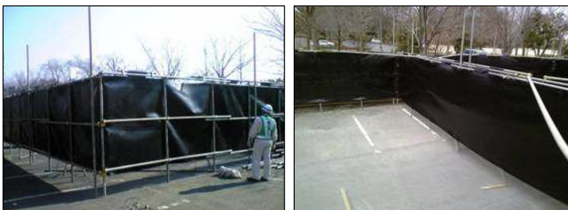
写真3-1 隔離水界の構造 (右：隔離水界の外側、左：隔離水界の内側)
