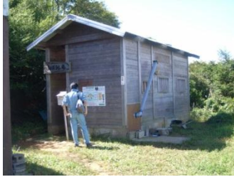
① トイレ全景
