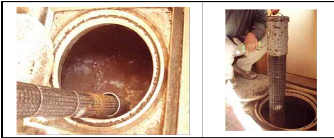
図 6-1-1 便槽の異物除去フィルター
