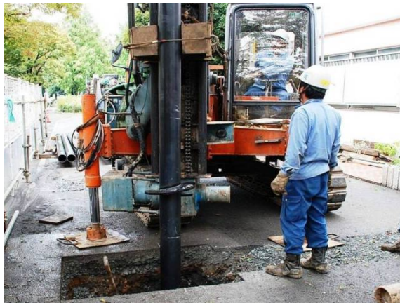
先端閉塞の回転貫入鋼管杭 (Φ165.2) の施工状況 (GL-30m まで設置)
