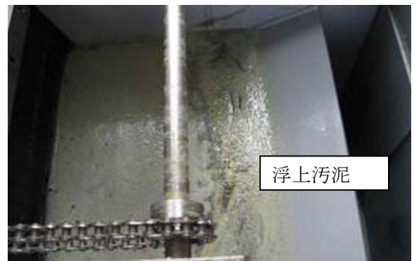
図9 浮上汚泥の集積
