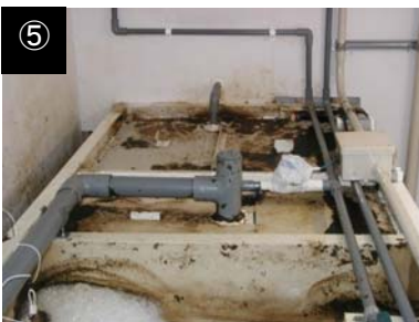
①トイレ外観 ②トイレ室内 ③受入槽(左)・貯留槽 ④前処理槽 ⑤分離槽・送水槽 ⑥オゾン反応塔
