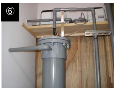
①トイレ外観 ②トイレ室内 ③受入槽(左)・貯留槽 ④前処理槽 ⑤分離槽・送水槽 ⑥オゾン反応塔
