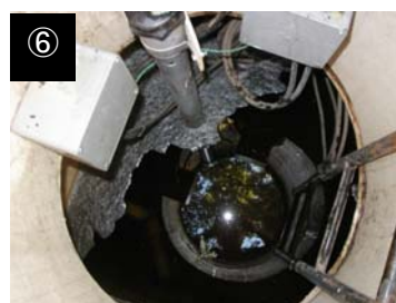
①正面 ②トイレ室内 ③受入槽 ④流動接触槽 ⑤高度処理ユニット・汚泥処理ユニット上部 ⑥集水槽
