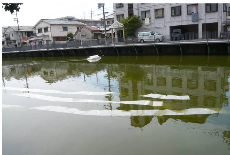
図4-1(2) アオコ制御施工装置 ロール紙敷設状況2(定期調査1回目)
