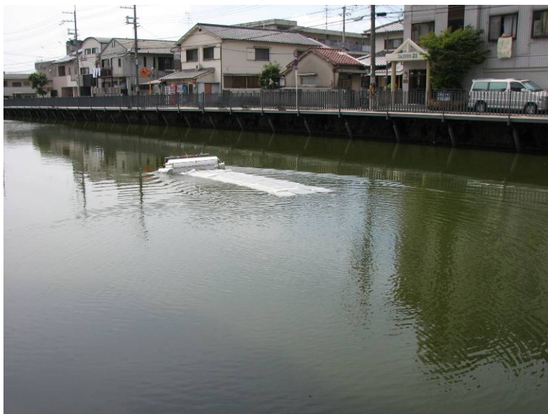
図4-1(1) アオコ制御施工装置 ロール紙敷設状況1(定期調査1回目)
