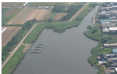
図-1 実証試験実施場所における隔離水塊の設置情況
